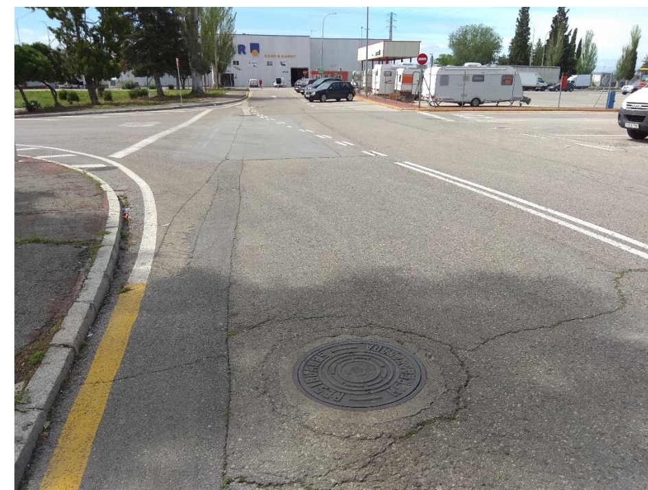
Tramo de la red de saneamiento existente donde se realiza la conexión de la nueva red de la zona ZAC
