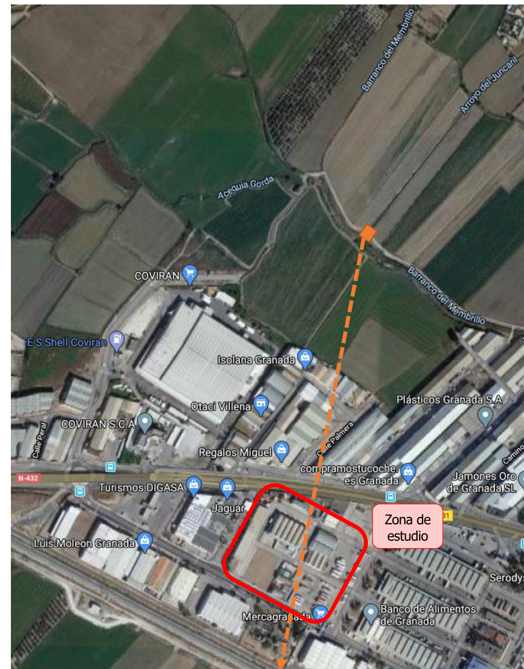
Colector desagüe Arroyo Juncaril y Bco. del Membrillo
