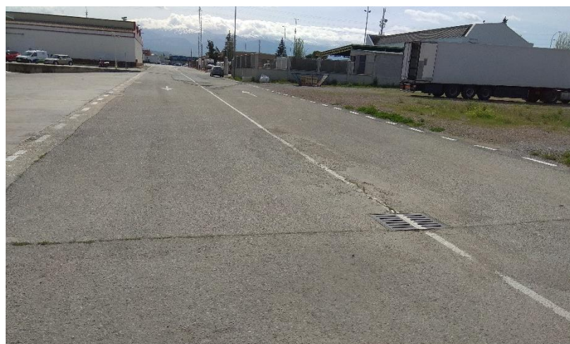
Rejilla de recogida de pluviales y registro de la red unitaria existente en la zona de ZAC
